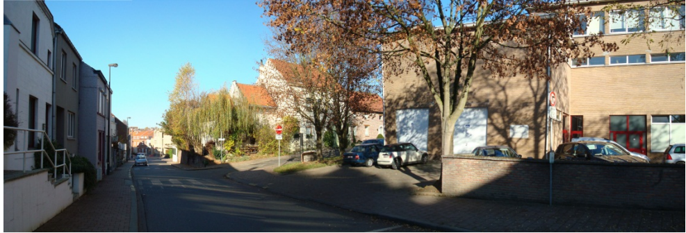
Het schoolgebouw op de hoek van de Waversesteenweg en de A. Mousinstraat met parking voor de school.
